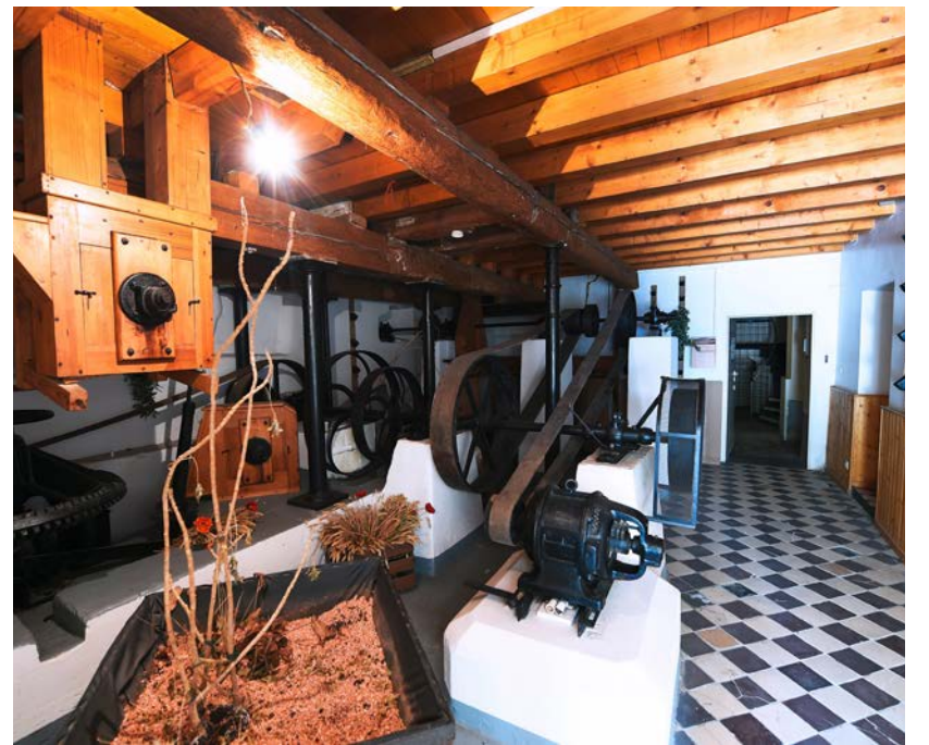
Endstation: Gleich im Eingang der Mühle steht die Anlage, aus der das fertig gemahlene Korn entnommen wurde
